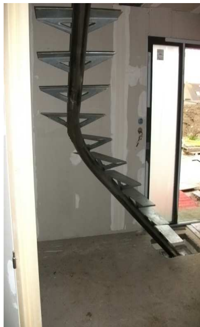
Escalier débillardé chez un particulier.
